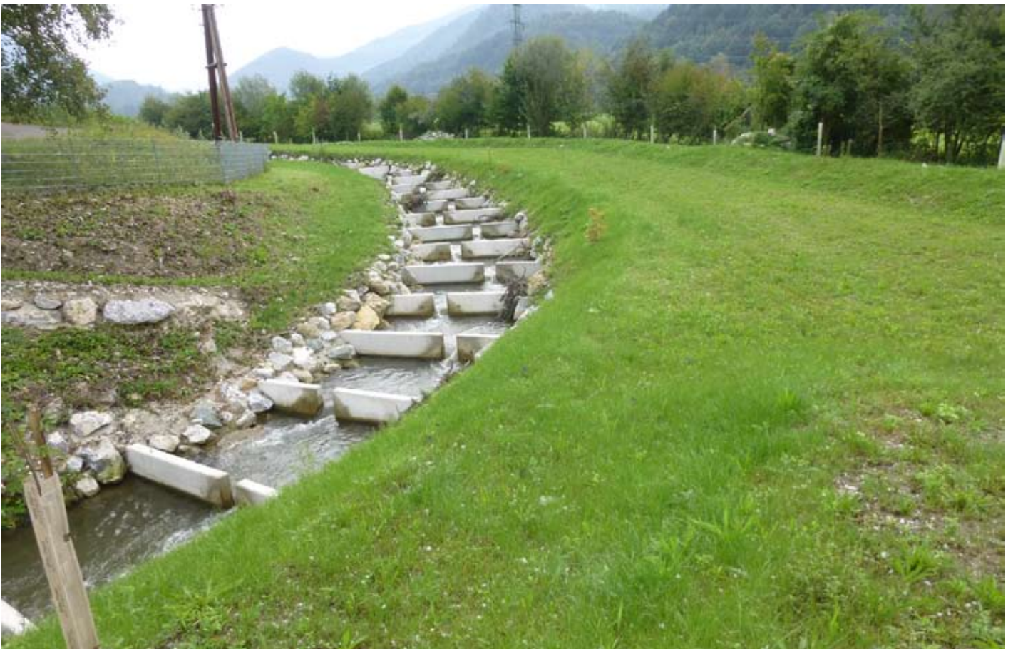
Fischaufstieg nach der Neophytenentfernung (KW Rabenstein)
