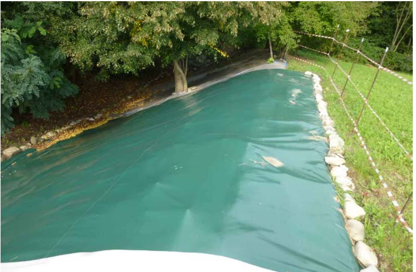
Neu aufgebrachte Folie auf der Hangwiese (KW Friesach), Bild oben und unten
