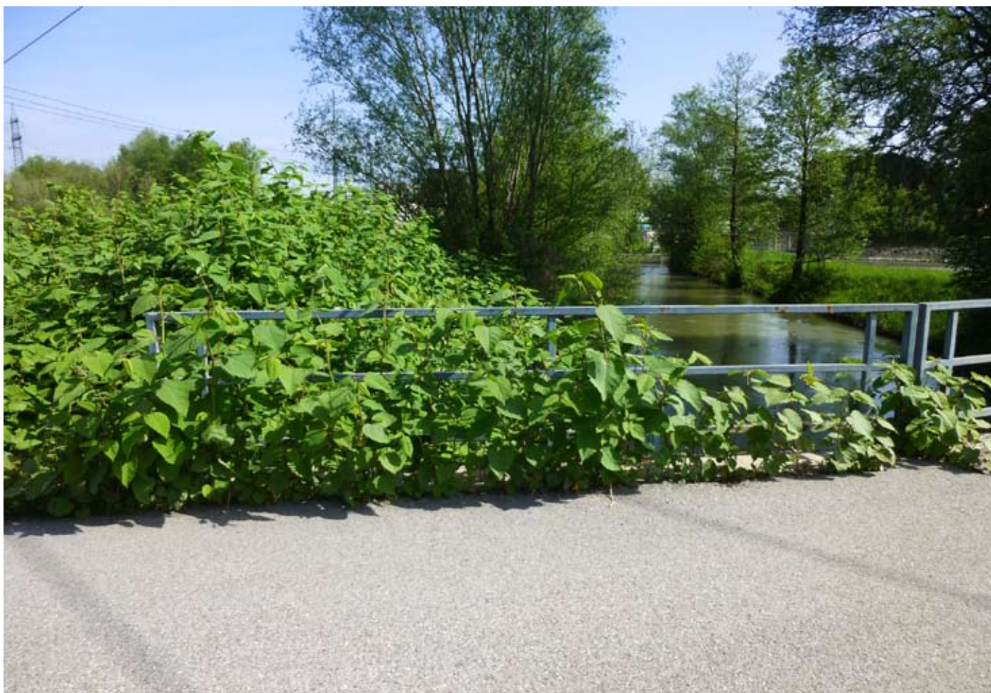
Wiederkehrender Staudenknöterichbewuchs im Bereich Brücke (KW Mellach 1)
