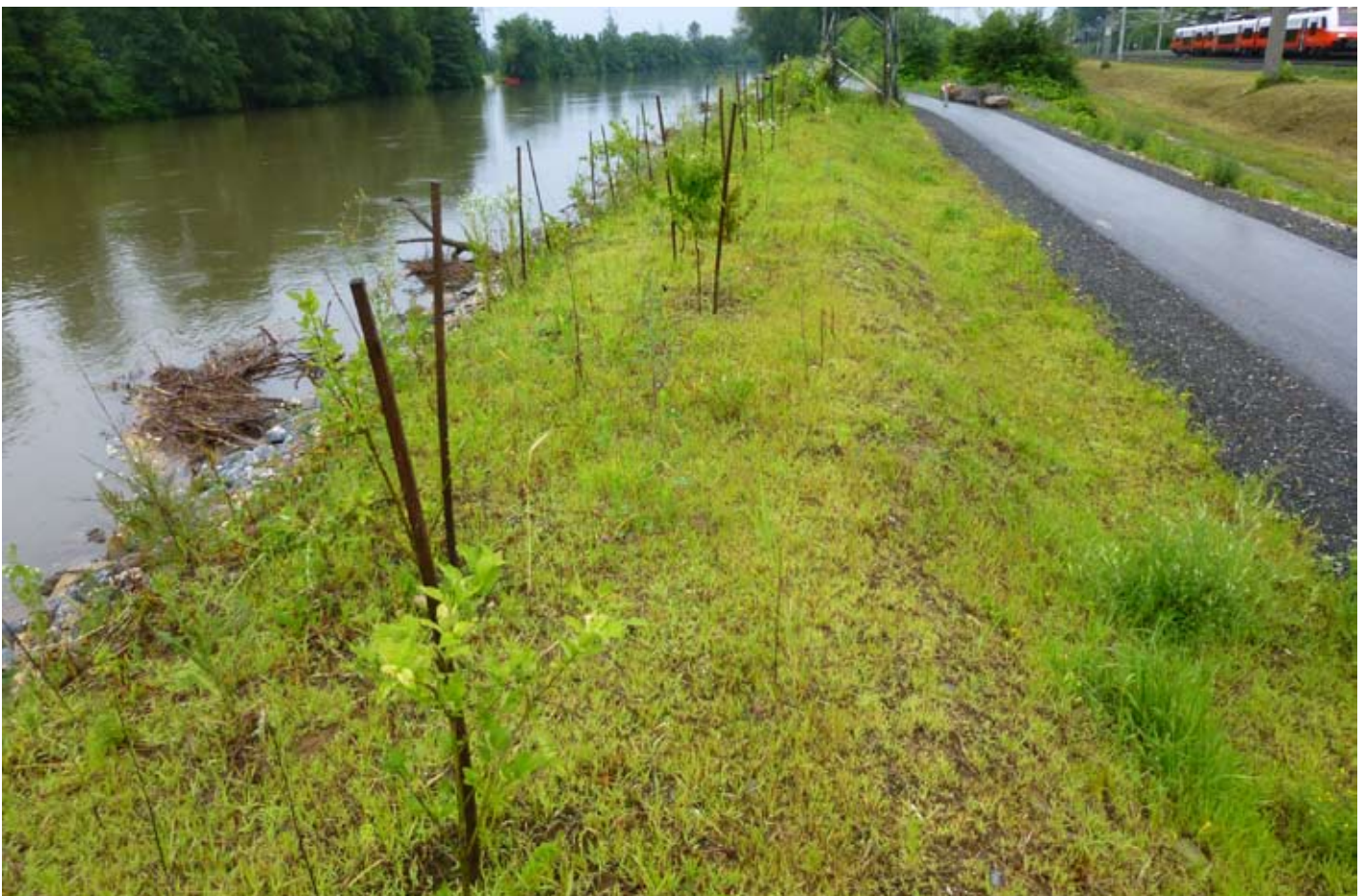
Gesäuberter Uferdamm (KW Lebring)
