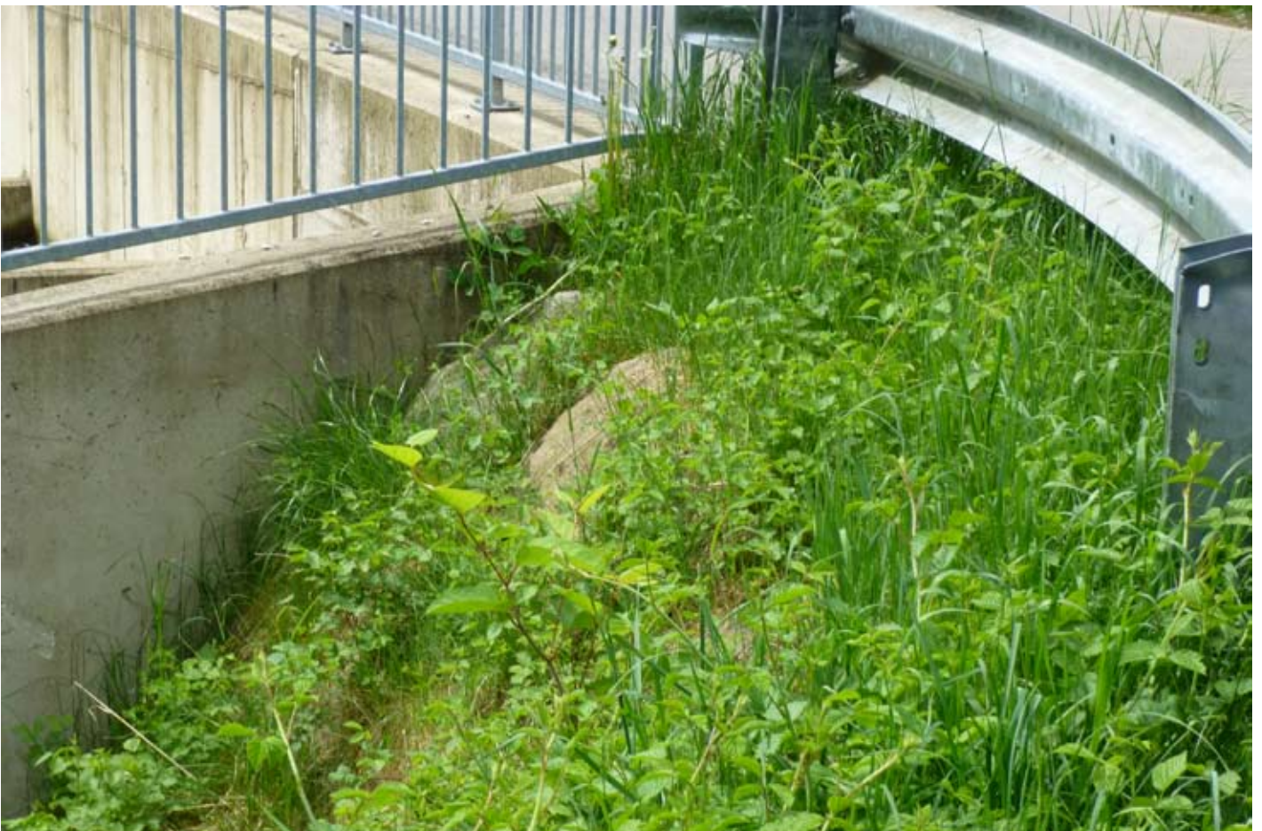
Staudenknöterichbereiche im oberen Bereich der Fischaufstiegshilfe (KW Obervogau), Bilder oben und unten
