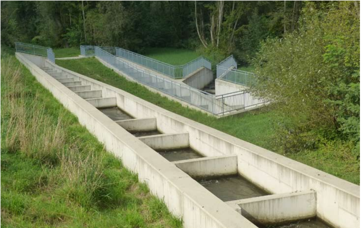
Areal Fischaufstieg Mellach (KW Mellach 2)
