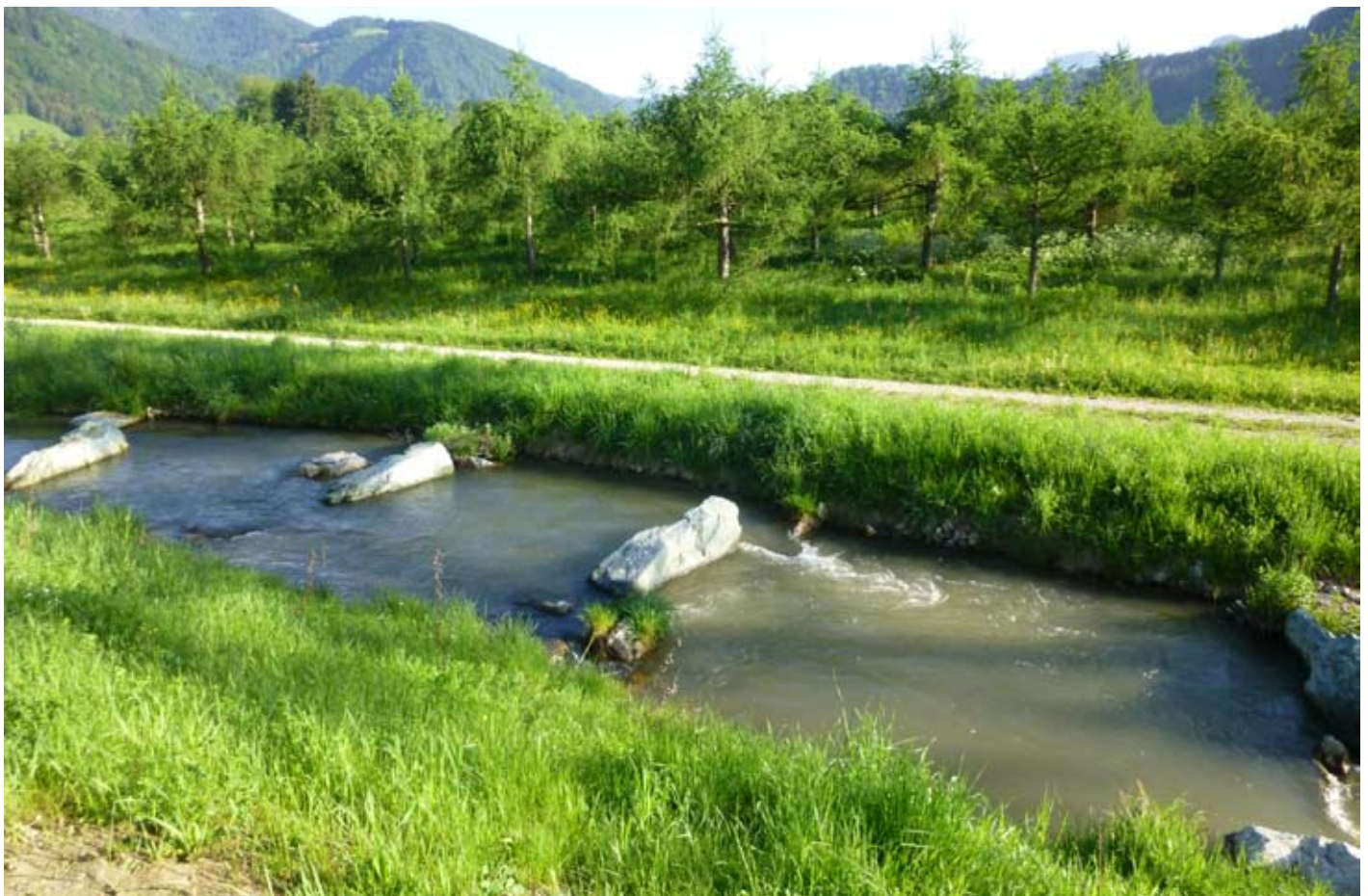
Ufer des Fischeufstieges (KW Peggau/Badl), Bild oben und unten
