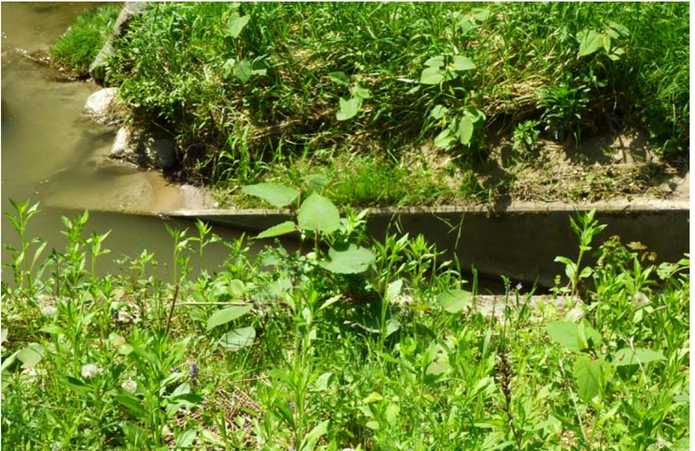
Junge Staudenknöteriche im Uferbereich der Fischeaufstiegshilfe (KW Spielfeld, Bereich Ehrenhausen), Bilder oben und unten
