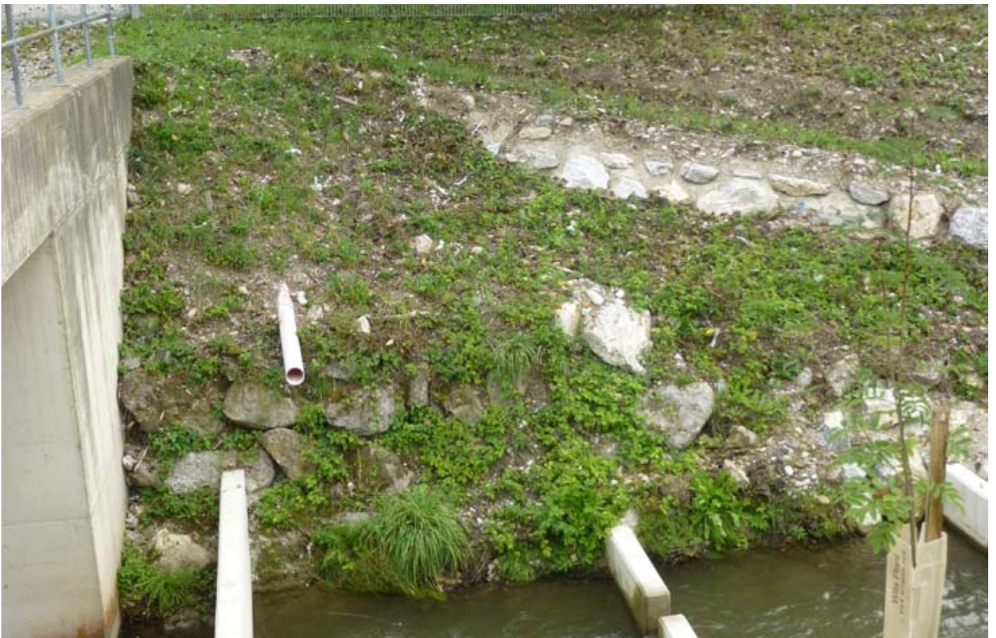
Gesäuberte Uferbereiche (KW Rabenstein), Bild oben und untens
