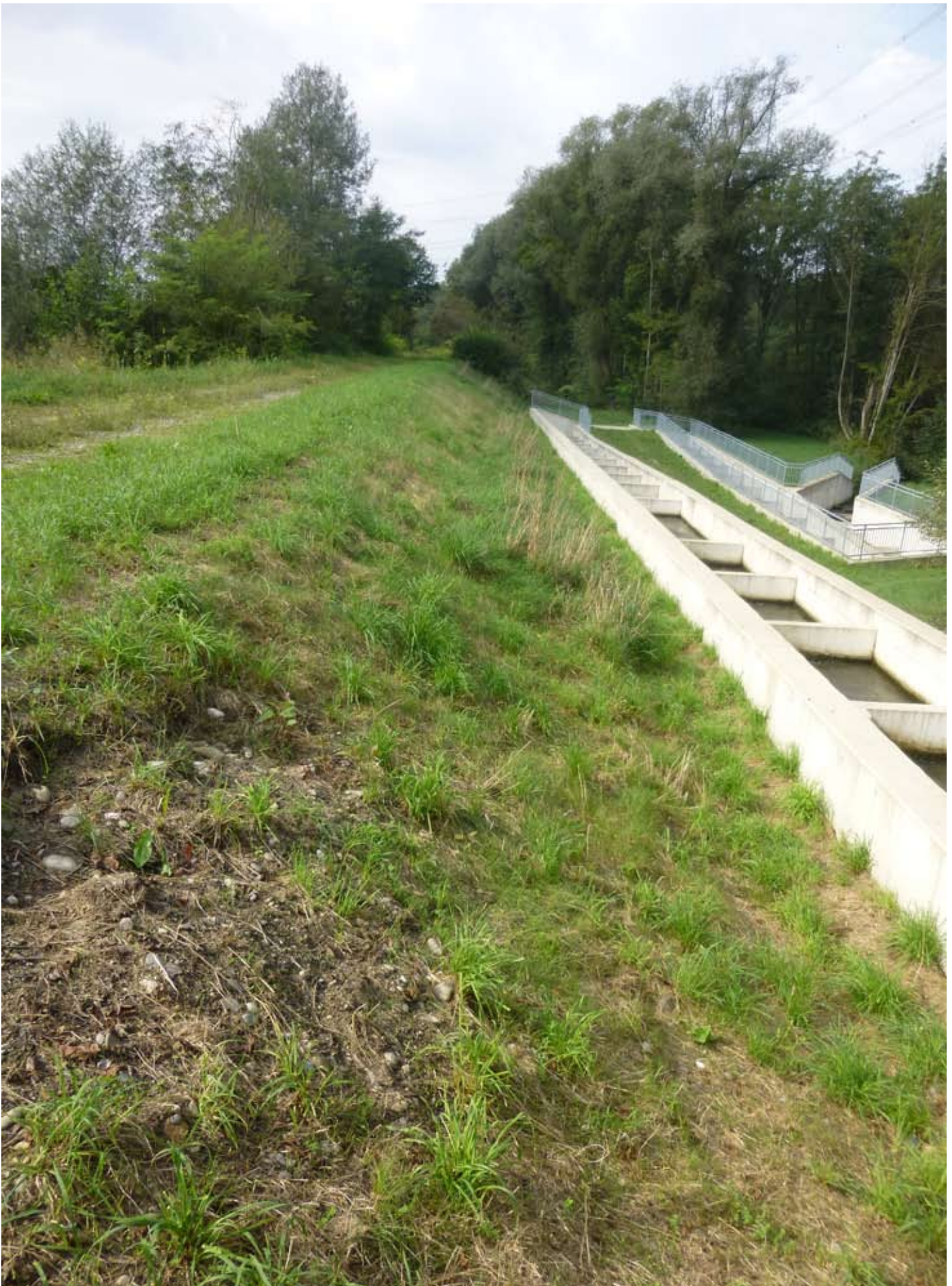
Gesäuberte Flächen nach Einsatz der Motorsense (KW Mellach 2)
