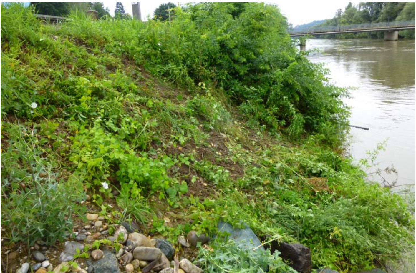
Gesäuberter Hangbereich, Staudenknöterich wurde entfernt (KW Lebring)
